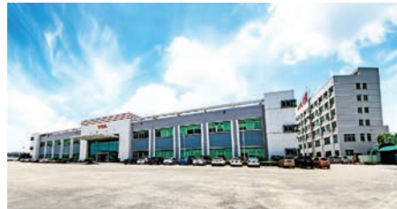
Jiujiang Base (2 εκ. σετ κλιματιστικών)
