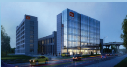
Νέα Βάση Wuhan (Βιομηχανικό Πάρκο 400.000m 2 )
