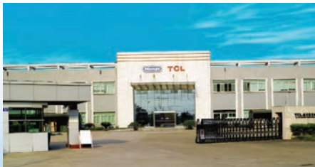
TCL De'longhi JV (1 εκ. φορτία κλιματιστικά & αφυγραντήρες)
